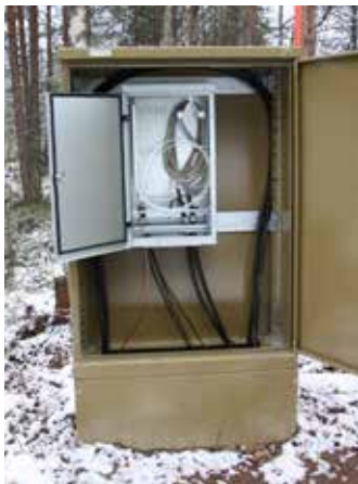
Kuva 8.10. Kylkiön periaate ja toteutus (Kuvat: Nestor Cables Oy)
