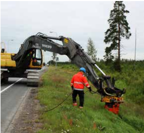
Kuva 7.17. Kaapeleiden aurausta (Kuvat: Nestor Cables Oy).
