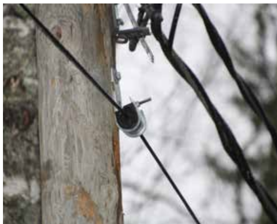
Kuva 7.26. Metalliton itsekantava (ADSS) ilmakaapeli asennettuna (Kuvat: Nestor Cables Oy).
