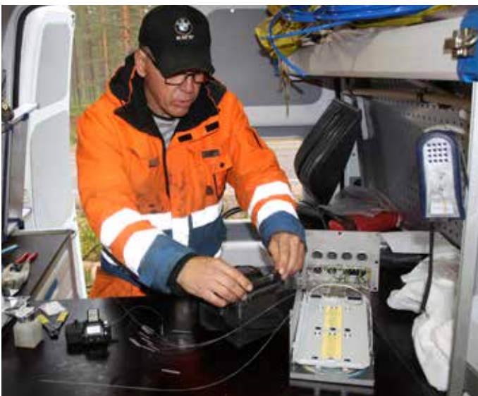
Kuva 8.4. Valokuidun jatkamista maastossa (Kuvat: Nestor Cables Oy).
