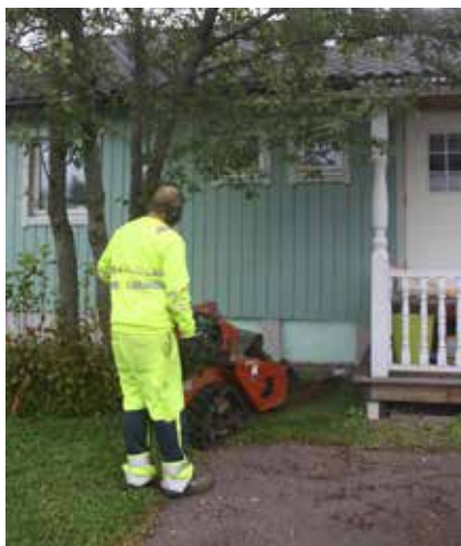
Kuva 7.22. Kaapeliuran jyrshintää taloliittymässä ketjukaivurilla (Kuvat: Nestor Cables Oy).
