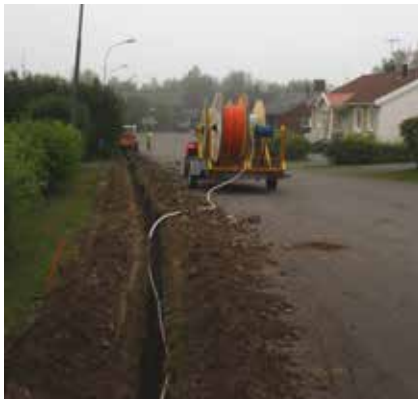
Kuva 7.21. Kaapeliuran jyrshintää sekä mikrokanavaputkien asennusta (Kuvat: Nestor Cables Oy).
