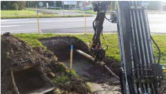
Kuva 7.24. Esimerkkejä tunkkauksesta ja suuntaporausesta (Kuvat Suomen Alitustekniikka Oy)
