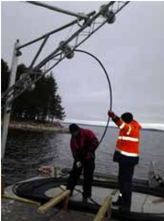
Kuva 7.29. Vesistökaapelin asennusta järveen (Kuvat Relacom Oy)
