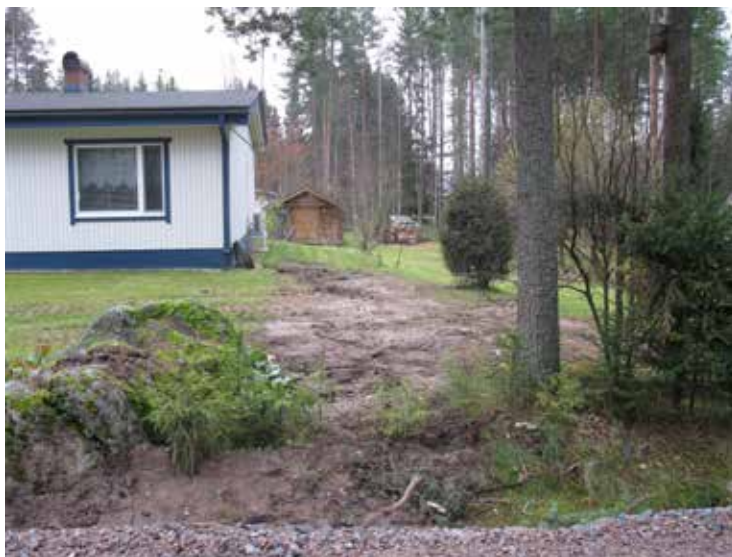
Kuva 7.35. Kaapelikieppi vedetty talon nurkalle odottamaan päättämistyötä (Kuva: Nestor Cables Oy).
