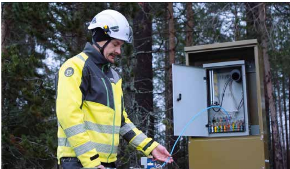
Kuva 7.12. Mikrokanavakaapelin puhallusta (Kuva: Nestor Cables Oy).
