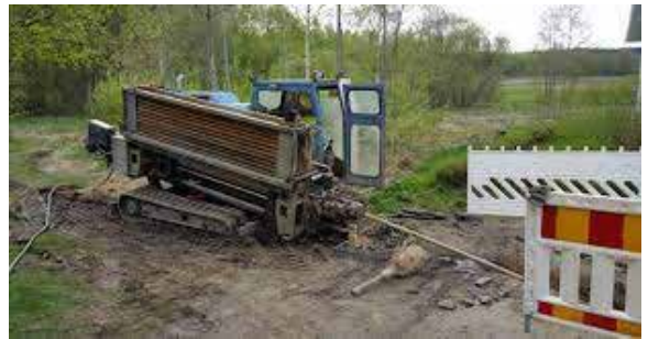
Kuva 7.24. Esimerkkejä tunkkauksesta ja suuntaporausesta (Kuvat Suomen Alitustekniikka Oy)
