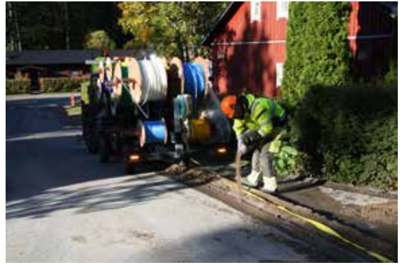
Kuva 7.20. Mikro-ojitusta pientaloalueella (Kuvat Nestor Cables)
