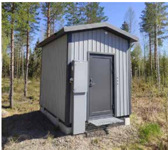
Kuva 6.9. Esimerkkejä liityntäverkkojen laittiloista (Kuvat: Televerkkopalvelut Seppo Marttila Oy, Nestor Cables Oy)
