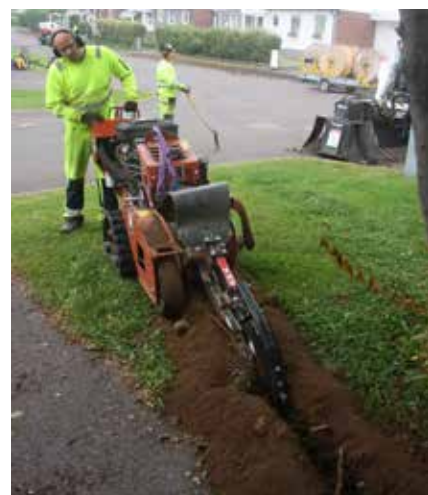
Kuva 7.22. Kaapeliuran jyrshintää taloliittymässä ketjukaivurilla (Kuvat: Nestor Cables Oy).
