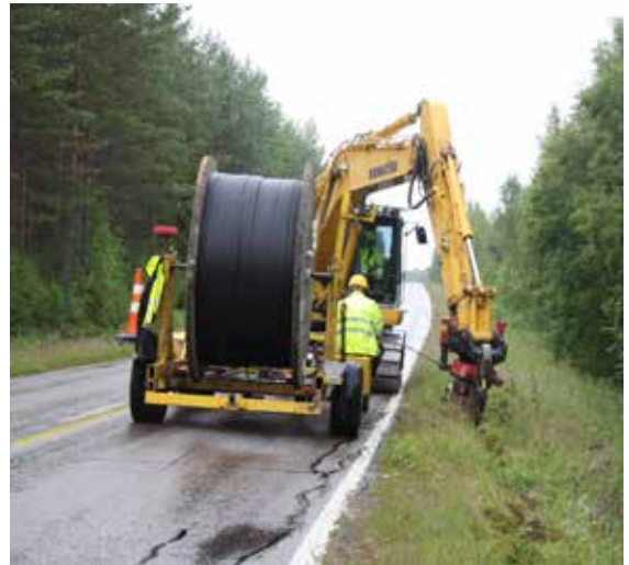
Kuva 7.17. Kaapeleiden aurausta (Kuvat: Nestor Cables Oy).
