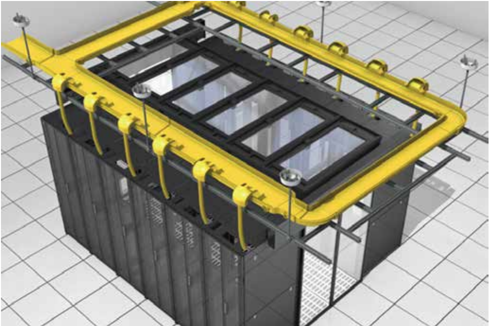
Kuva 8.17. Esimerkki kuituhyllyistä laitetilassa.
