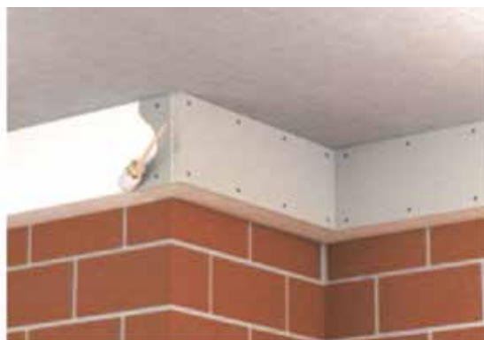
Palosuojakanava voidaan tasoittaa ja maalata, jolloin se on siisti ja huomaamaton.
