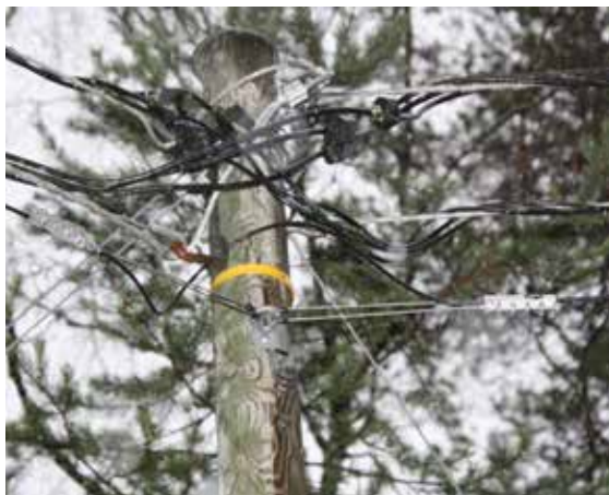
Kuva 7.26. Metalliton itsekantava (ADSS) ilmakaapeli asennettuna (Kuvat: Nestor Cables Oy).
