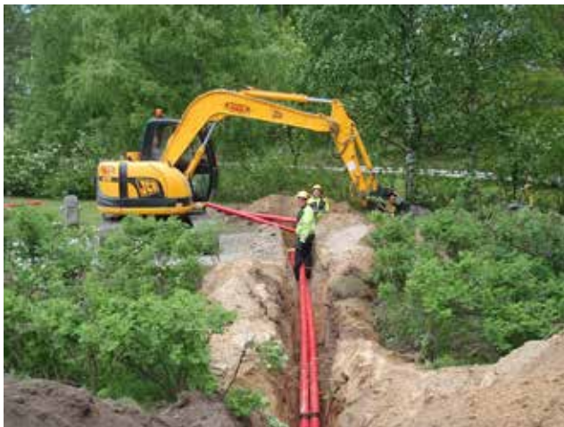
Kuva 7.5. Kanavaputkiston asennusta (Kuva: Veljekset Toivanen Oy).
