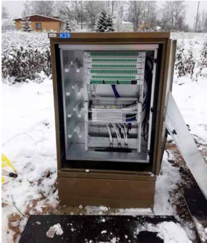
Kuva 6.8. Jaottimia sijoitettuna ulkoristiyhteyden kaappiin (Kuva: Televerkkopalvelut Seppo Marttila Oy).
