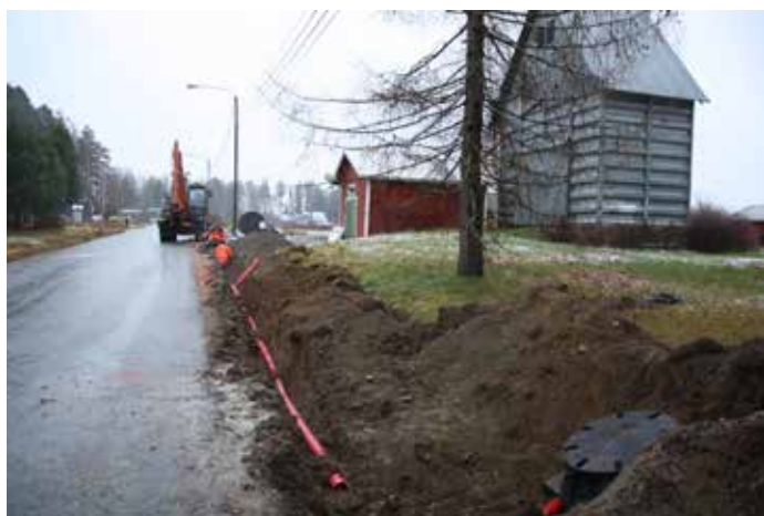
Kuva 7.15. Maakaapeleiden suojaus matala-asennuksessa muovikourulla (Kuva Nestor Cables Oy)
