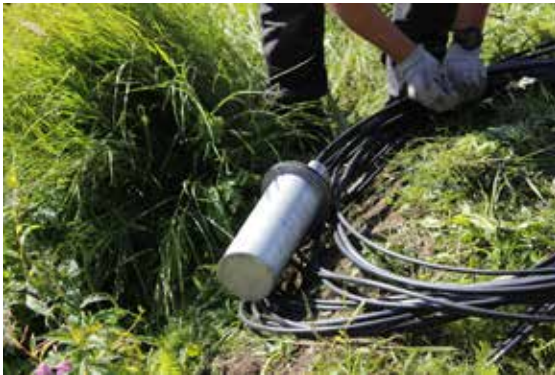
Kuva 4.28. Asennettuja ulkojatkoskoteloita (Kuvat Nestor Cables Oy).
