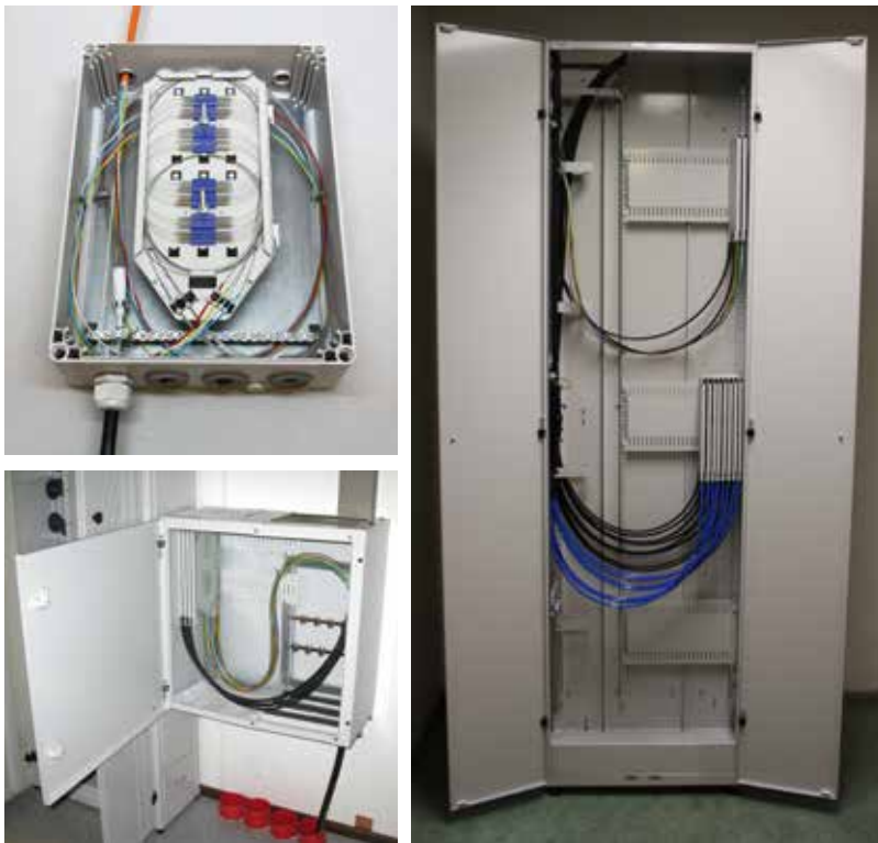
Kuva 4.30. Esimerkkejä asennetuista sisäjatkoskaapeista (Nestor Cables Oy).
