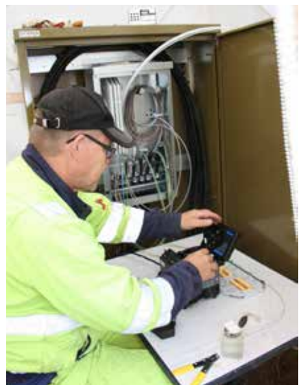
Kuva 8.4. Valokuidun jatkamista maastossa (Kuvat: Nestor Cables Oy).
