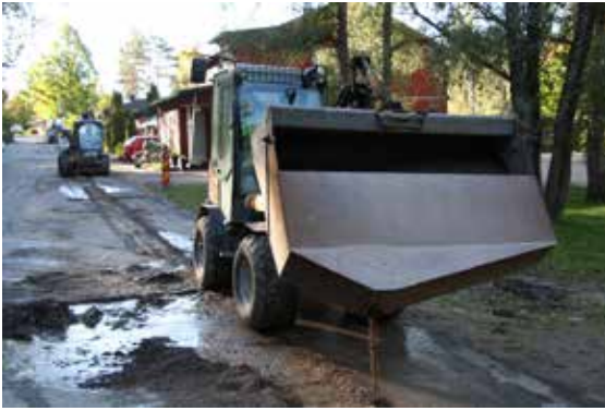
Kuva 7.20. Mikro-ojitusta pientaloalueella (Kuvat Nestor Cables)
