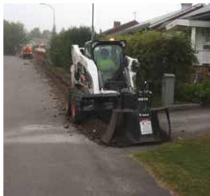
Kuva 7.21. Kaapeliuran jyrshintää sekä mikrokanavaputkien asennusta (Kuvat: Nestor Cables Oy).
